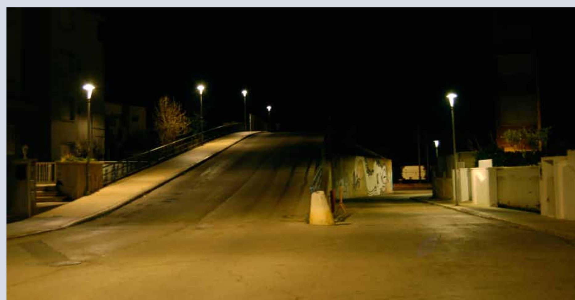
La Carrerada de Santa Coloma és una de les vies que ja compta amb el nou enllumenat d'alta eficiència.
