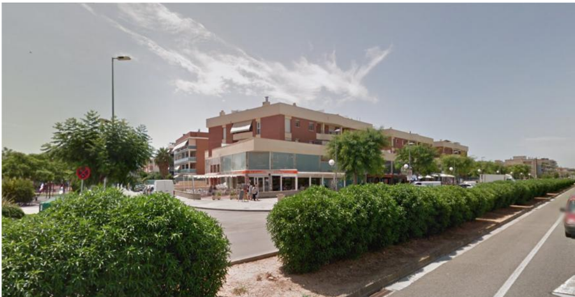
Vista de l'edificació des de l'avinguda Barcelona direcció oest
