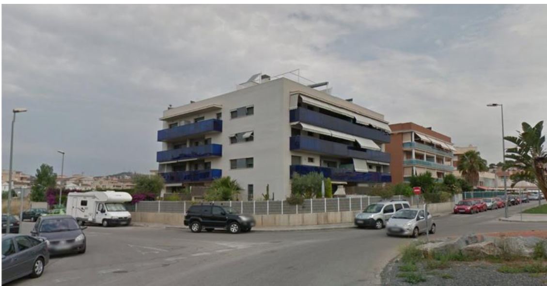
Vista de l'edificació a la cantonada de la Rambla del Prat i l'avinguda del Castell
